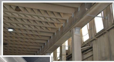
Cemento armato prefabbricato vincolato (incremento capacità di resistere alle azioni sismiche)
